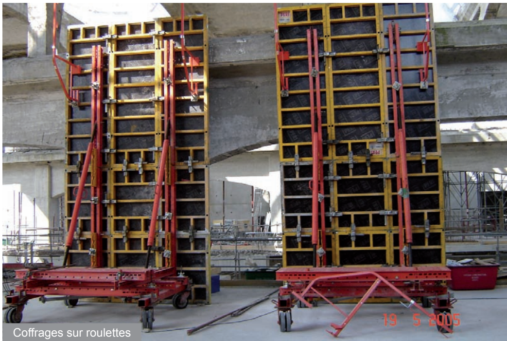
Voiles coulés sous poutre
