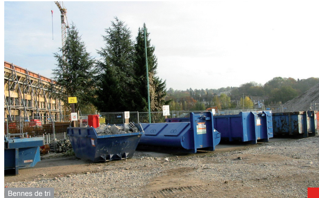
Fosse de décantation
